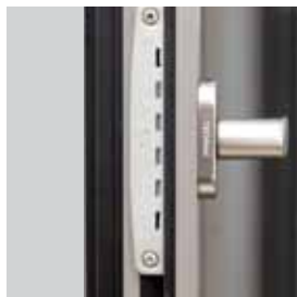
Maniobra de los cierres por cremóna encastrada bidireccional
